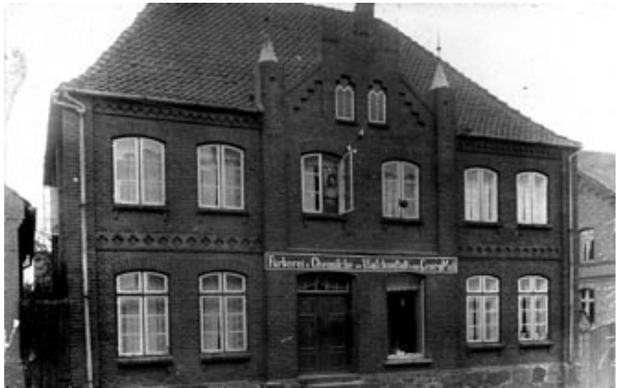
Abb. 9, Färberei & Chemische Waschanstalt von Georg Moll
