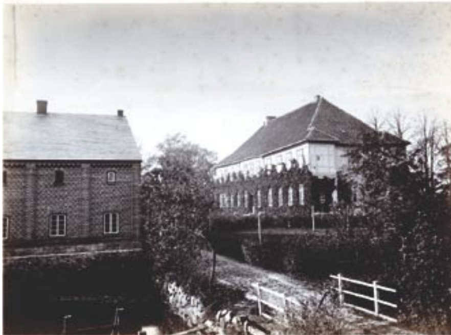
1: Gutshaus Neuenhagen, um 1890. Ähnlich sahen das Gutshaus und der Pferdestall links im Bild auch noch 1909 aus, als Familie Rolfs dort einzog. Beide Gebäude sind noch heute erhalten. Am Gutshaus wurde allerdings zu DDR-Zeiten vor die Hauptfassade aus Fachwerk eine Ziegelmauer gesetzt. Bildquelle: Landeshauptarchiv Schwerin, Fotosammlung Mencke, LHA SN 13.3-1 Nr. 381.tif
