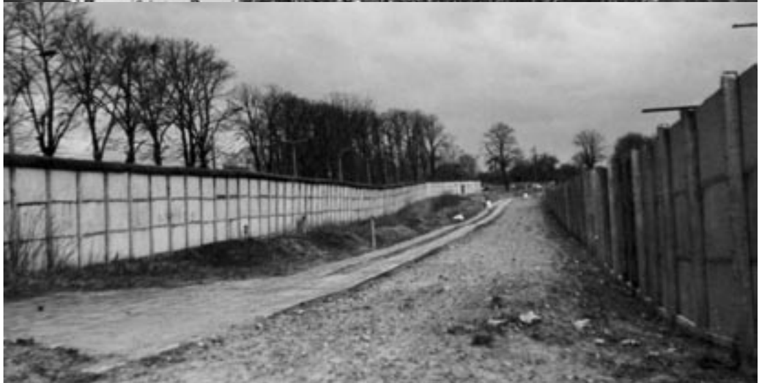
Doppelte Sperranlage mit Metallstreckzaun und Mauer Richtung Schwanbeck
