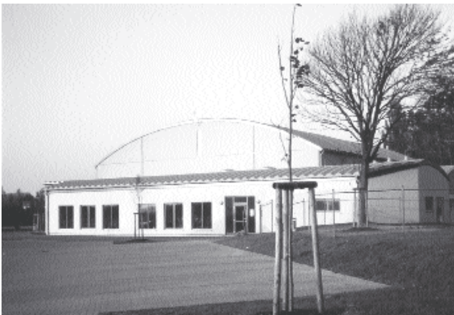
Die neue Mehrzweckhalle in Dassow. Der Heimatuverein gratulierte mit der Pflanzung eines Baumes zur Einweihung.
