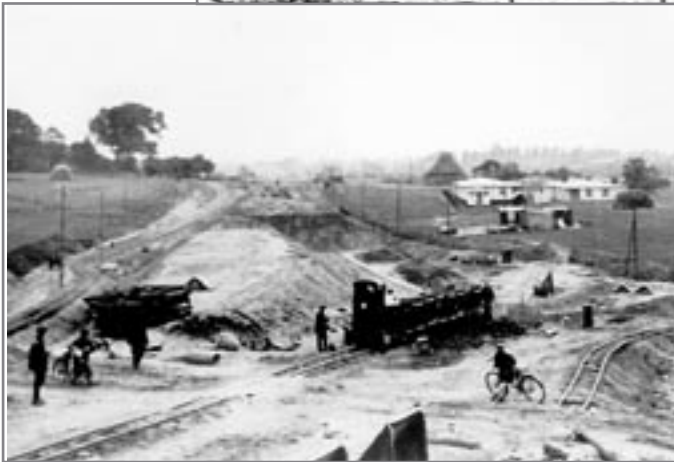
Bauarbeiten an Bahndamm und Chaussee nach Pötenitz. Blick von NO, links Bäume des Domänenhofbereiches, rechts „Schafstall“ Prehn und Arbeiterbaracken
